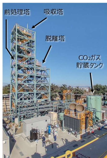
図2 CO 2 分離・回収設備（当社熊谷工場）
